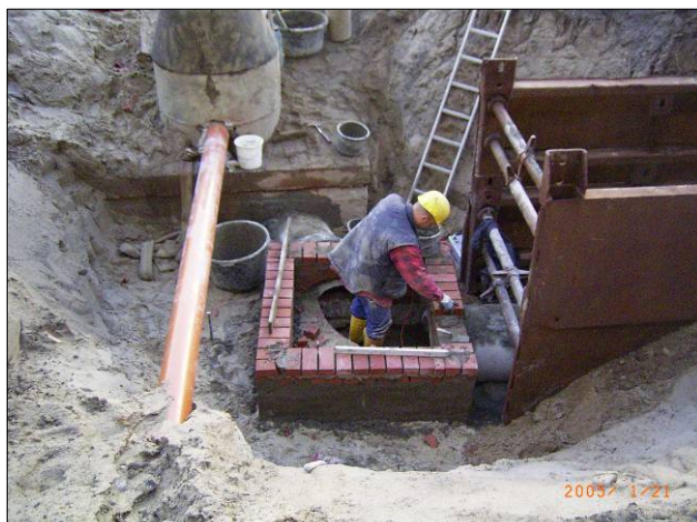
Örtlich hergestelltes Schachtunterteil
