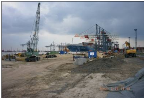
Baufeld vor Beginn der Arbeiten
