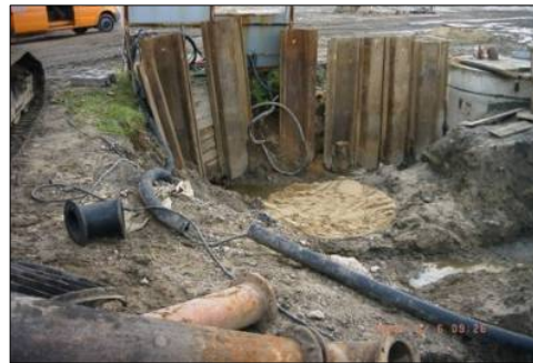
Typisches Bild einer Baugrube
