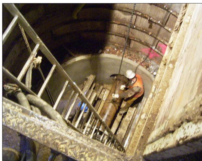
Blick in die Startbaugrube
