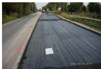
Ausbau unter Vollsperrung
