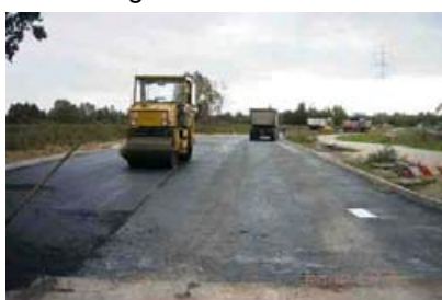
Gewerbegebietzufahrt wird endgültig ausgebaut, incl. Nebenflächen
