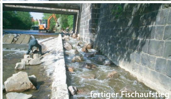
Einsetzen von Störsteinen
